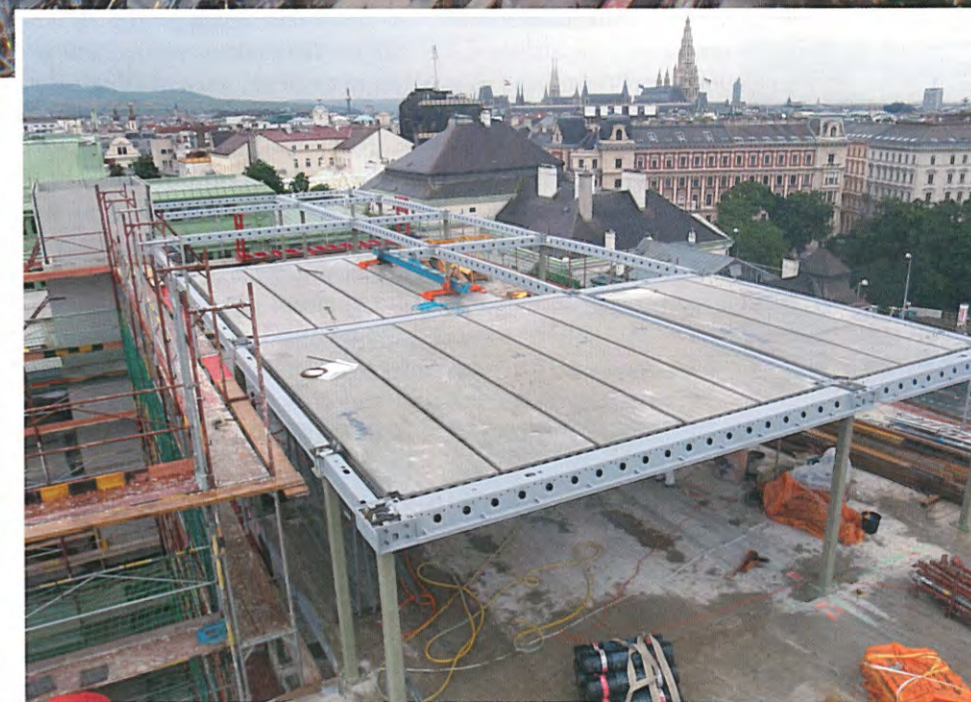
Die Bilder zeigen neben der schlanken Stahlverbundkonstruktion der Aufstockung auch die beengte Baustellensituation.
