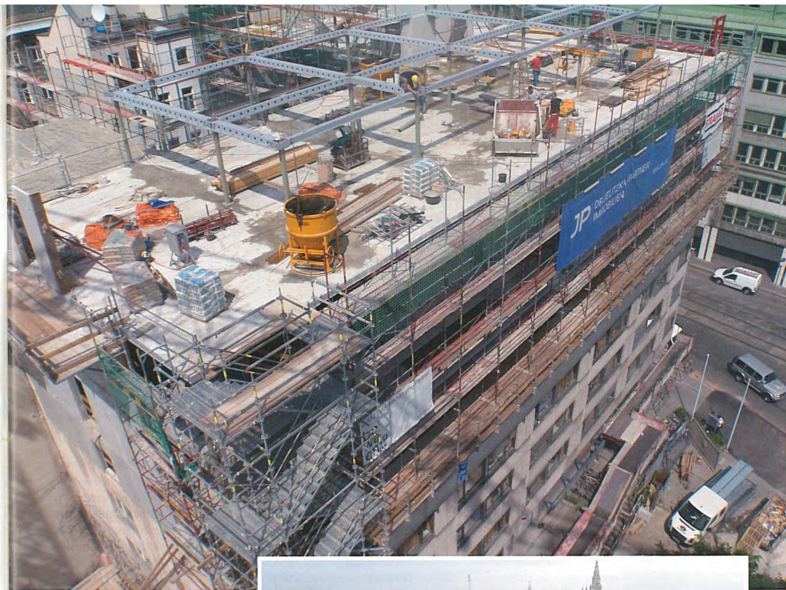
Die Bilder zeigen neben der schlanken Stahlverbundkonstruktion der Aufstockung auch die beengte Baustellensituation.
