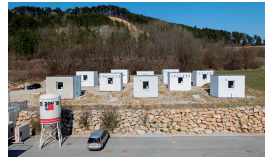
Baustoffe im knallharten Test: Baumit leistet sich einen Forschungspark mit zehn Testhäusern, jedes mit anderen Baustoffen gebaut. Das Ziel ist, festzustellen, welche Baustoffe am gesündesten sind. Zudem werden Aspekte wie Nachhaltigkeit und Energieeffizienz unter die Lupe genommen.
