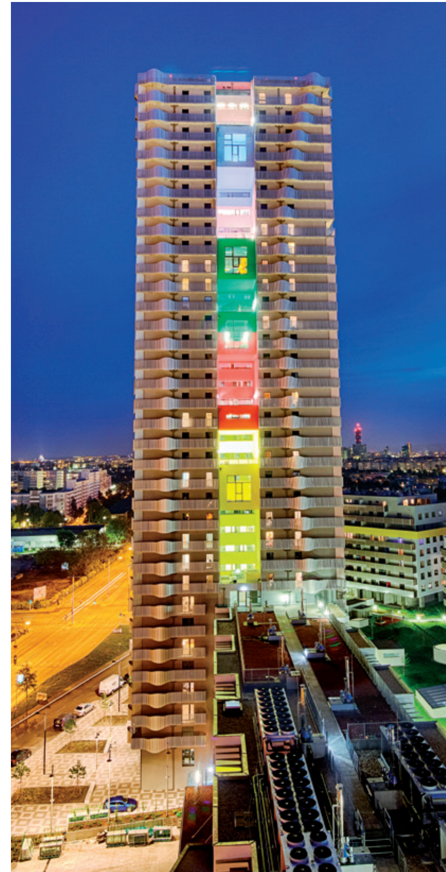
Citygate-Tower: Gemischte Bewohnerstruktur wie auch Wohnform – Miete und Eigentum – Von Singles bis junge Paare, Familien und älteren Menschen. Querkräft Architekten planten den 34 Stockwerke hohen Wohnbau in Floridsdorf.
