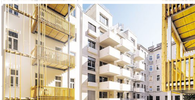
Wolfshof in Meidling von Gerner Gerner Plus: Holzverkleidete Balkone ragen in den neu geschaffenen Innenhof
