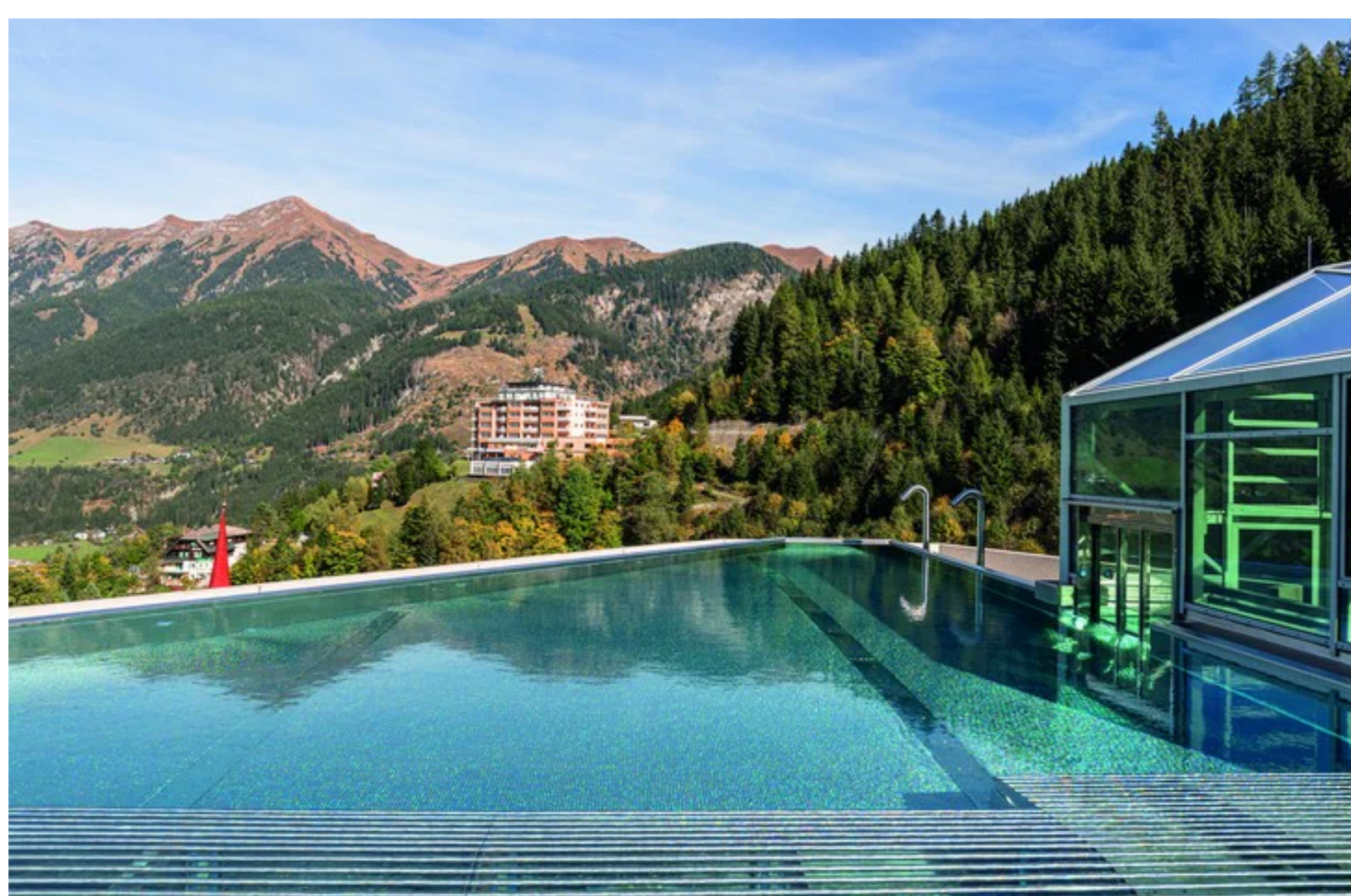
Vom Pool im hat man einen uneingeschränkten Blick auf das Gasteiner Tal. (Foto: © Atelier Wolkersdorfer)
