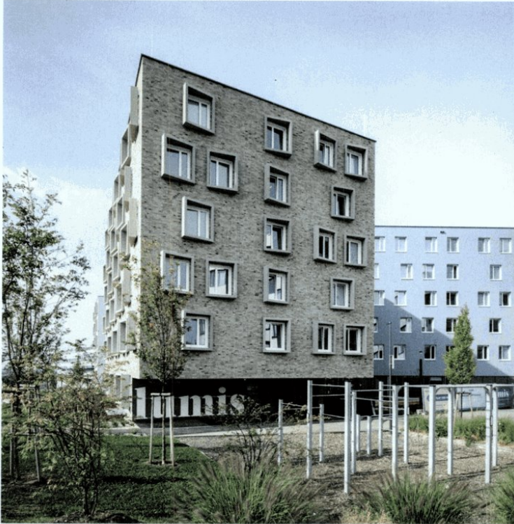
Micro-Living mit Mehrwert Studierendenwohnheime und Serviced Apartments wie hier auf dem Campus Altes Landgut (Bauträger: DYWIDAG) sind weiter im Kommen. dywidag.at
